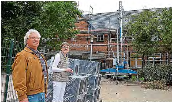
Leezens Bürgermeister und Amtsvorsteher Ulrich Schulz begutachtet mit Pastorin Anett Penner den Fortschritt der Umbau- und Sanierungsmaßnahmen am Gebäude der kirchlichen Kita. Nach der Dachsanierung wird angebaut. FOTO: HARALD BOCKEN
