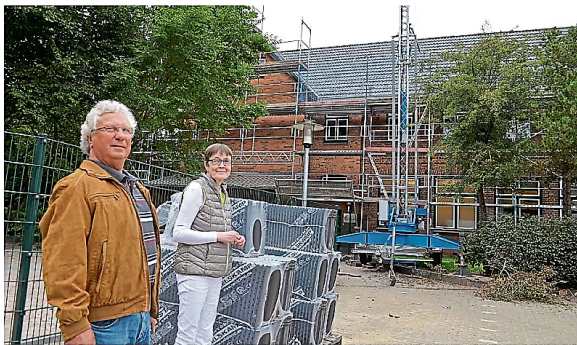
Leezens Bürgermeister und Amtsvorsteher Ulrich Schulz begutachtet mit Pastorin Anett Penner den Fortschritt der Umbau- und Sanierungsmaßnahmen am Gebäude der kirchlichen Kita. Nach der Dachsanierung wird angebaut. FOTO: HARALD-BECKER
